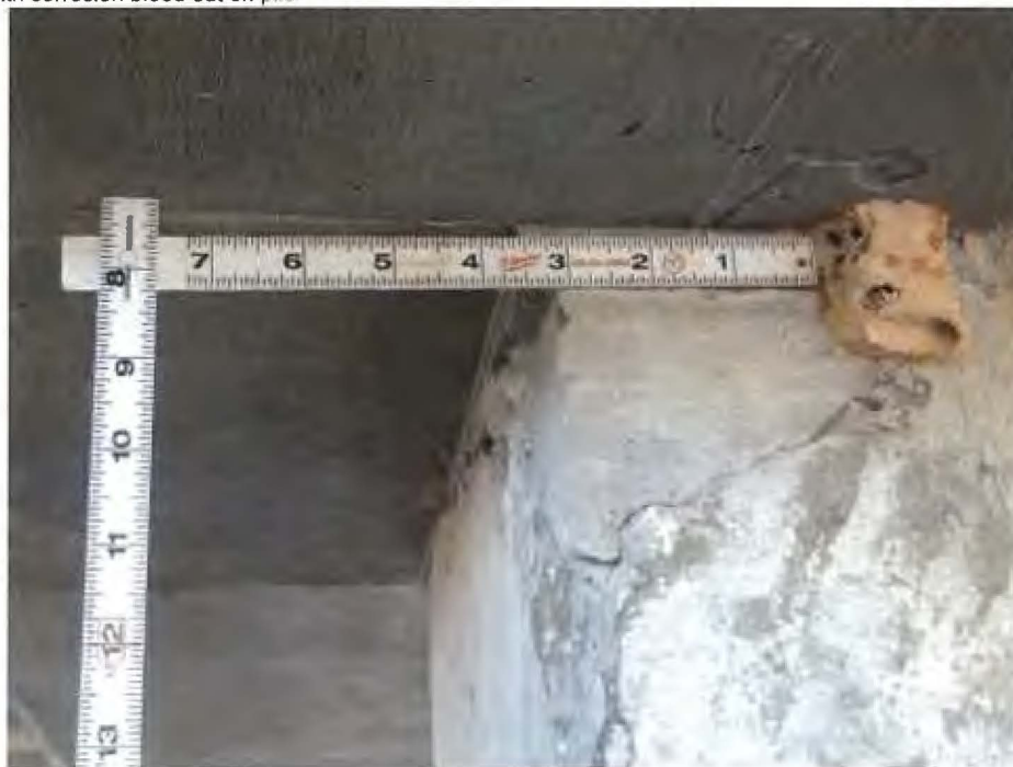
227 - Re Conc Pile
