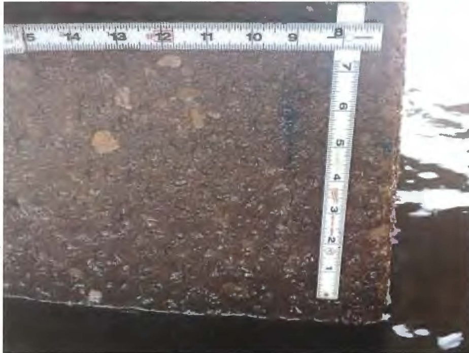
227 - Re Conc Pile
