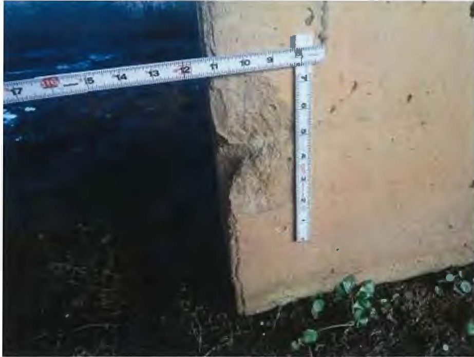
227 - Re Conc Pile
