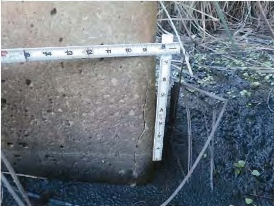
227 - Re Conc Pile
